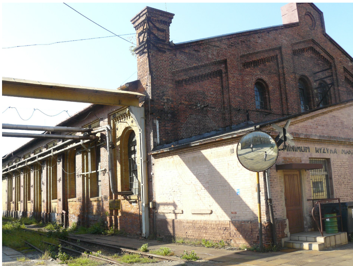
Ilustracja 42: Hala walcowni blach przy W.M. Dziedzice
