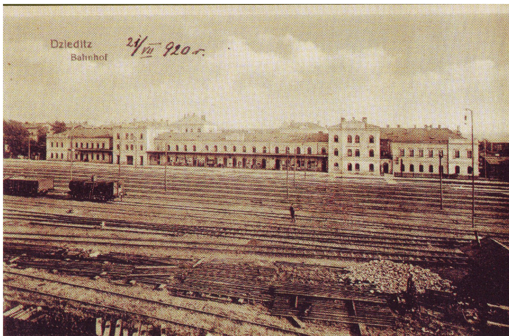
Ilustracja 39: GŁÓWNY BUDYNEK DWORCA CZECHOWICE-DZIEDZICE; „Dziedzice Czechowice na starych widokówkach”
