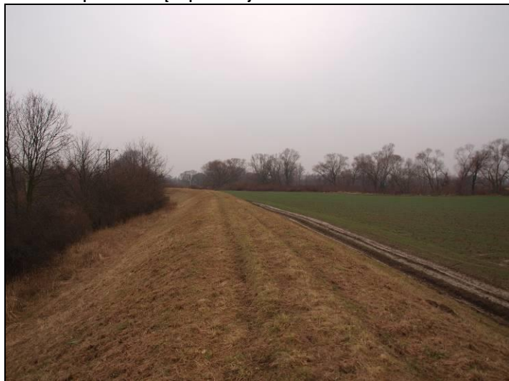
Fot. 6 Wał przeciwpowodziowy i dolina Hłownicy (poza terenem mpzp od strony zachodniej)
