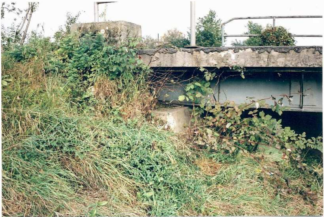
Fot.2. Widok od strony zachodniej na przyczółek północny. Aby nie naruszać struktury wałów nie przewiduje się ich rozbiórki. Pozostawione elementy przyczółków znajdują się ponad poziomem wielkiej wody Q_{1\%} .
