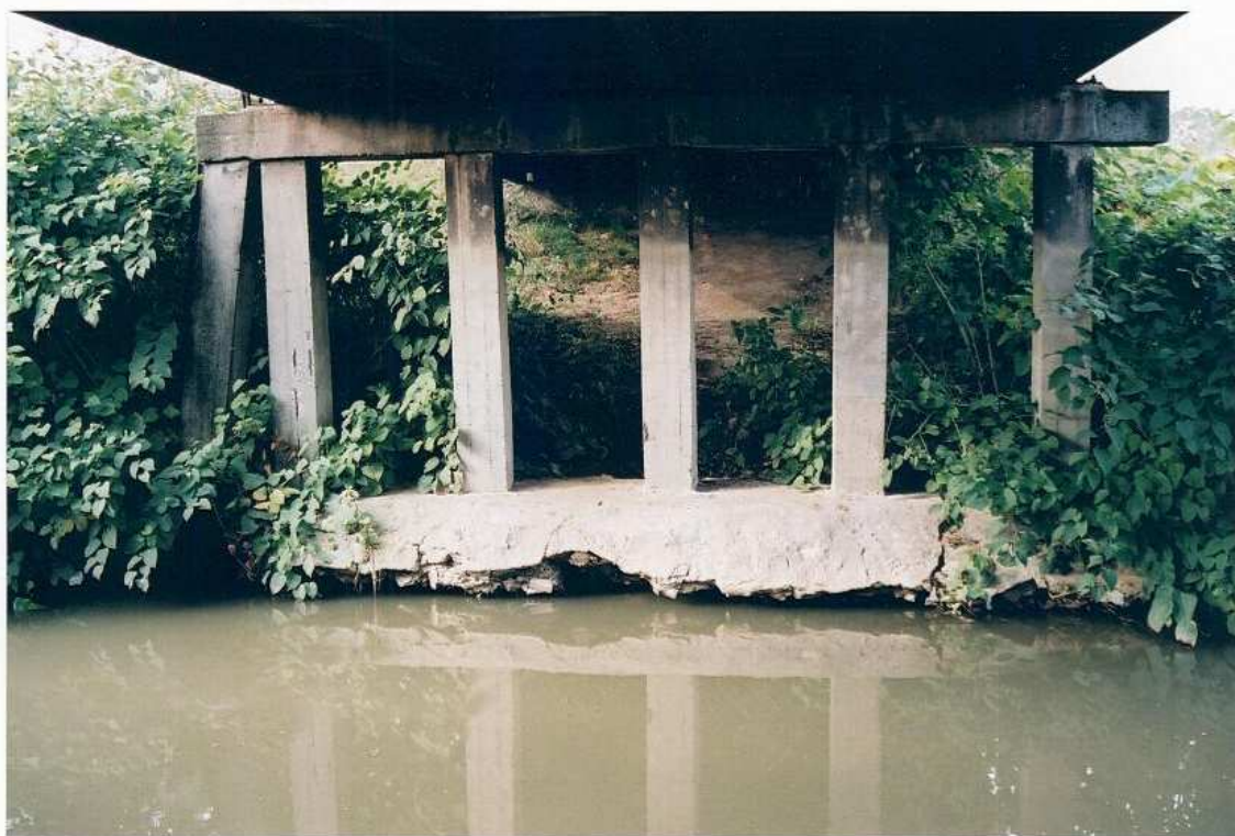
Fot.3. Widok na filar północny. W wyniku erozji dna potoku fundament filara uległ zniszczeniu.
