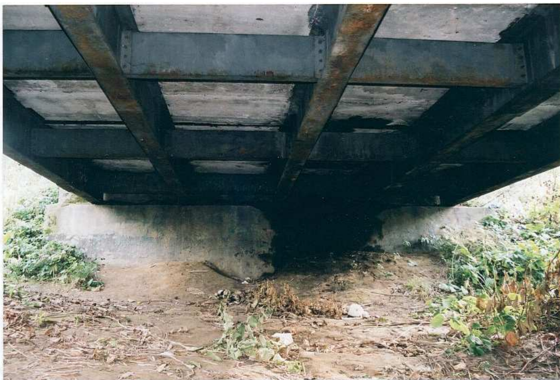
Fot.5. Widok od spodu na konstrukcję nośną i przyczółek południowy. Konstrukcja stalowa mostu jest w stosunkowo dobrym stanie technicznym.
