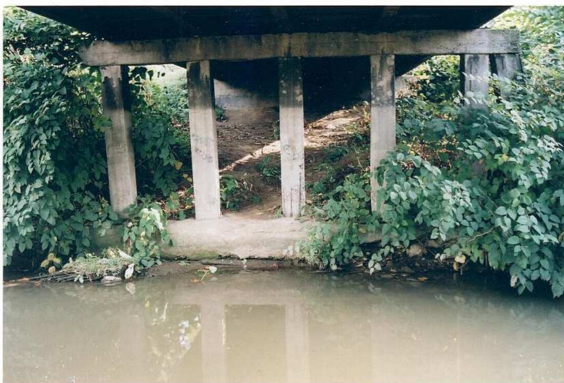
Fot.4. Widok na filar południowy. Na zdjęciu widoczny jest spód ławy fundamentowej – powyżej lustra wody.
