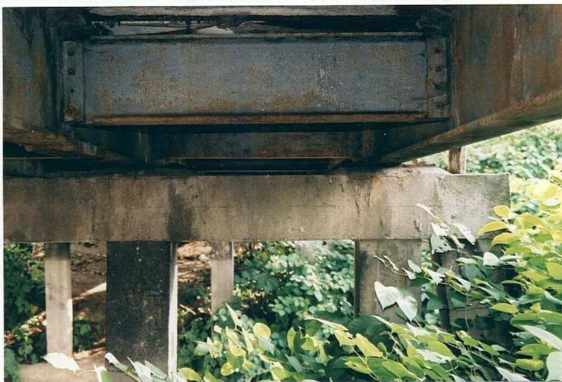
Fot.6. Widok na głowicę filara północnego. Belki nośne zostały ustawione na oczepie za pośrednictwem łożysk stycznych (blachy łożyskowe).
