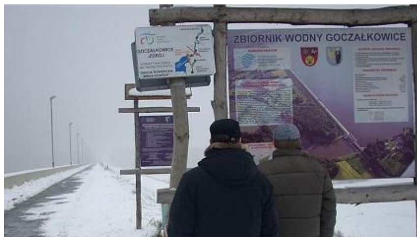
Korona wału zapory Zbiornika Goczałkowickiego jest atrakcyjnym celem wycieczek
